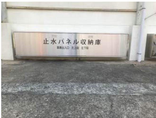
止水パネル収納庫を側壁に固定
