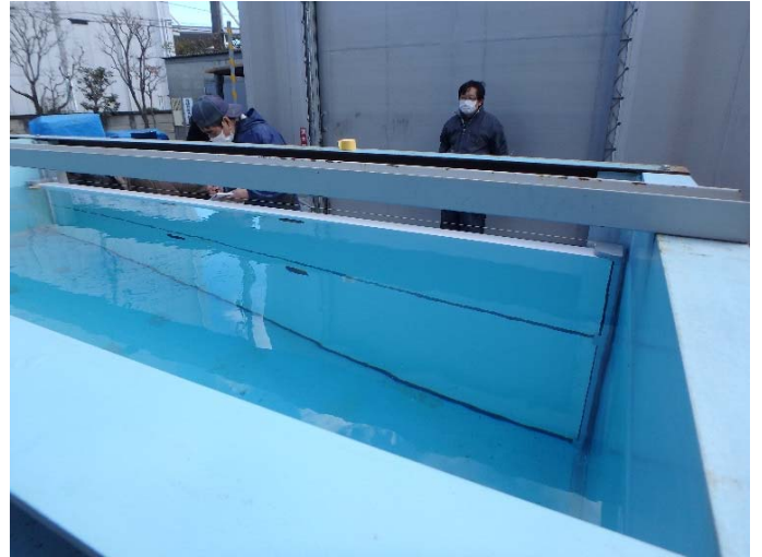
専用プールで 水深1mの水圧テスト<例>
