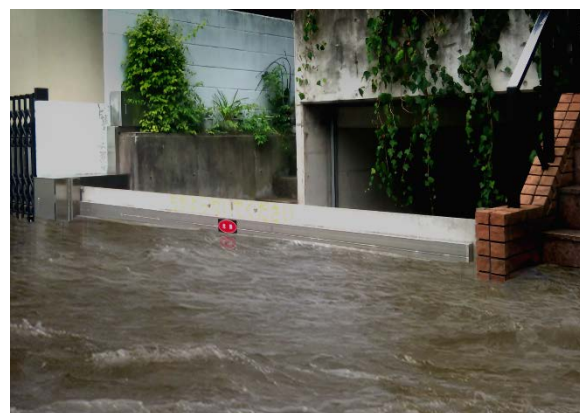
地下駐車場入り口に設置した止水板
