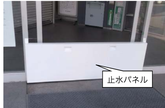
パネル設置後
