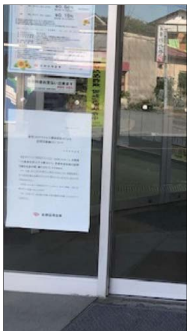
取り付け工事前
